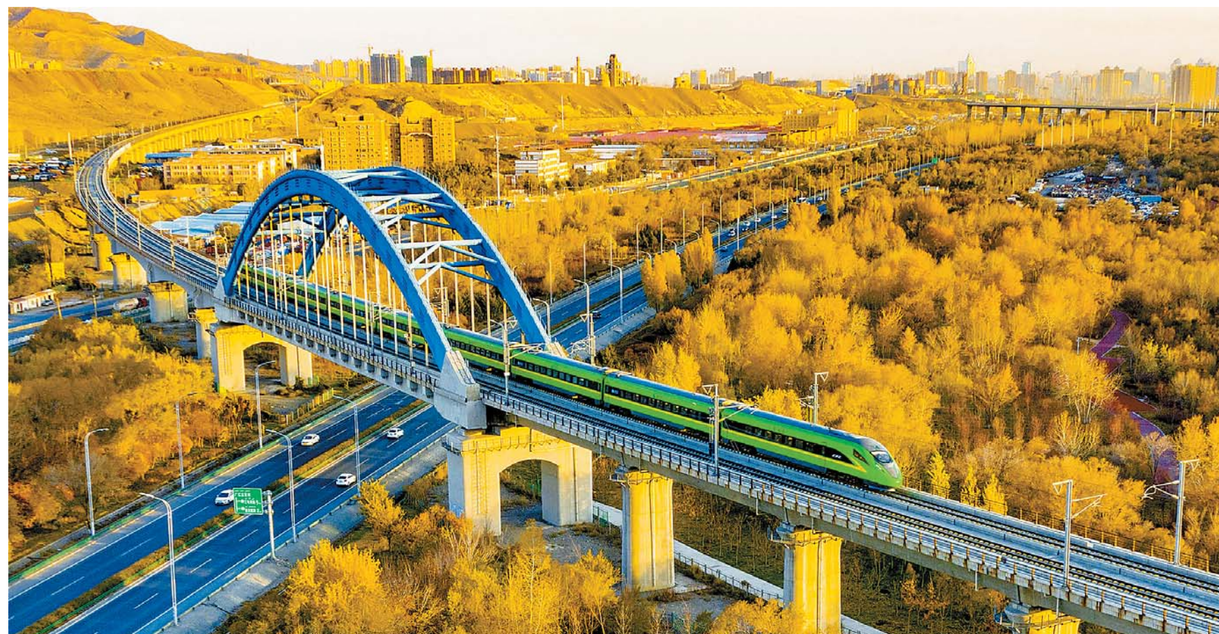
10 - ايدىڭ 18 - كۈنى فۇشىڭ ئومۇمى CR200J تىپى ەلەكترلى موتورلى ۇاڭوندار قۇراماسى تاك شۇعلاسىنا مانا ۇرۇمچى قالاسى يان - بىرۋە بولەگىنەن ۇتسپ باردى. قازىر ۇرۇمچى تىنمەن ايتانداي ماۋسەمعا ەندى، موتورلى ۇاڭوندار قۇراماسى ارسانان كەسپىپ ونگەندە كورگەم كورنىس قالپتاستىردى. □ سۆزەتتى گازەتمىزدىڭ جاپىلىق اقبارات قۇرالدارى ەتلىشىسى ساي زىڭلى تۇسىرگەن
